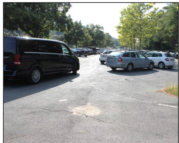
Abbildung 9: Parkplatzbereich des Schwimmbads
